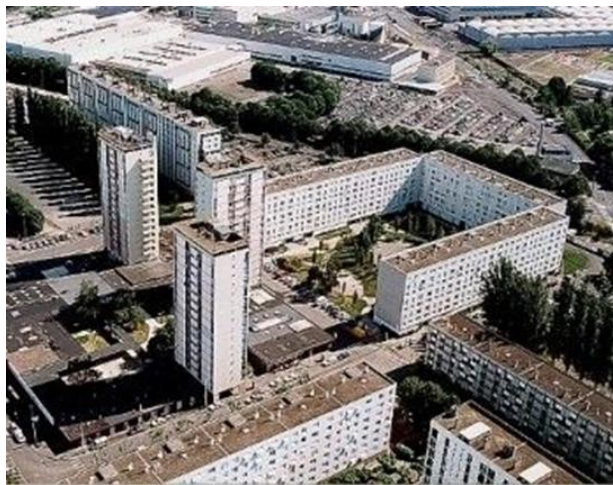
Figure 6 : Photo aérienne du quartier de la Gauthière (Source : La Montagne, 2012)
