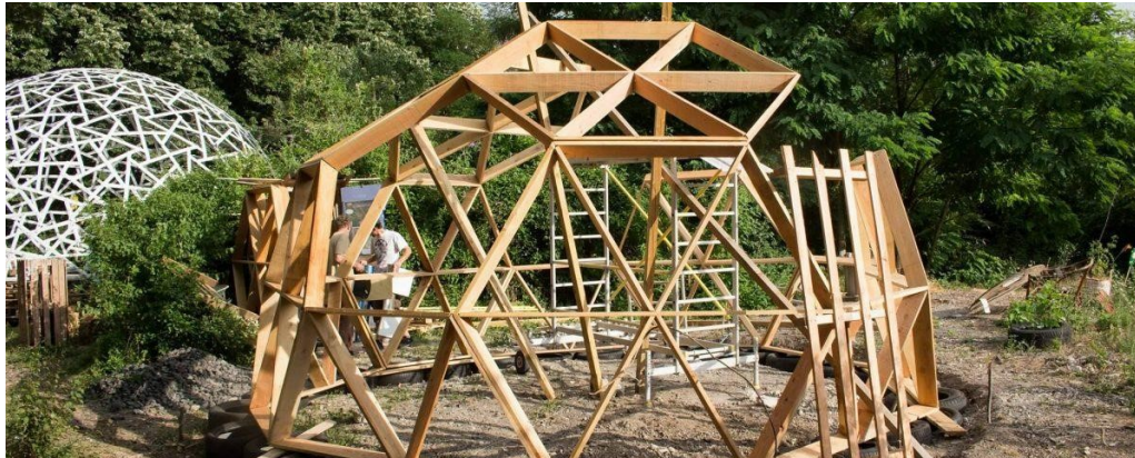
Figure 13 : Construction des paligloos par le collectif Parcc Oasis (Source : LieU'topie, 2017)
