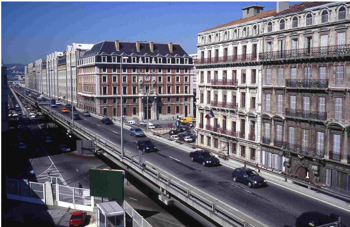
Figure 23 : Passerelle autoroutière en plein centre-ville de Marseille génératrice d'externalités négatives, source : madeinmarseille.net
