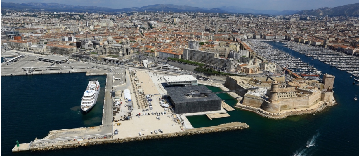
Figure 50 : Promenade Robert-Laffont et Louis Brauquier vue du ciel, Source : présentation powerpoint A. Sorrentino
