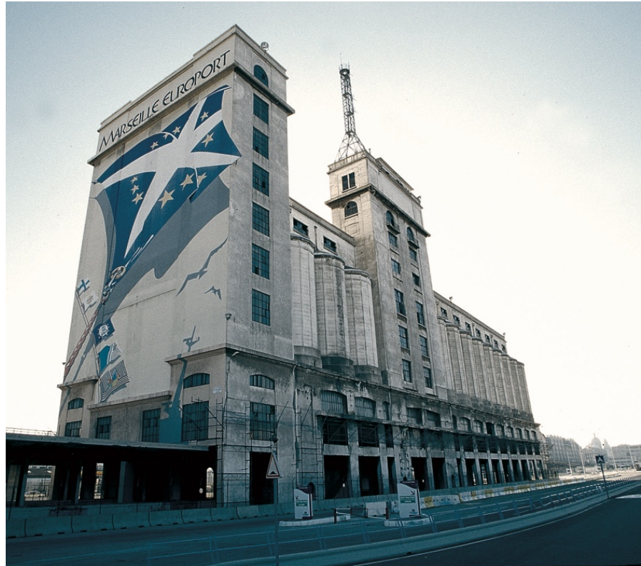
Figure 25 : Silo de Marseille, source : présentation powerpoint Alexandre Sorrentino
