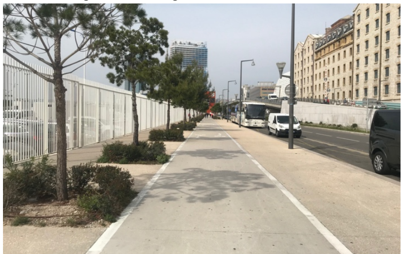
Figure 42 : Piste cyclable sur trottoir sur la portion 3 du boulevard, Source : Ville de Montréal
