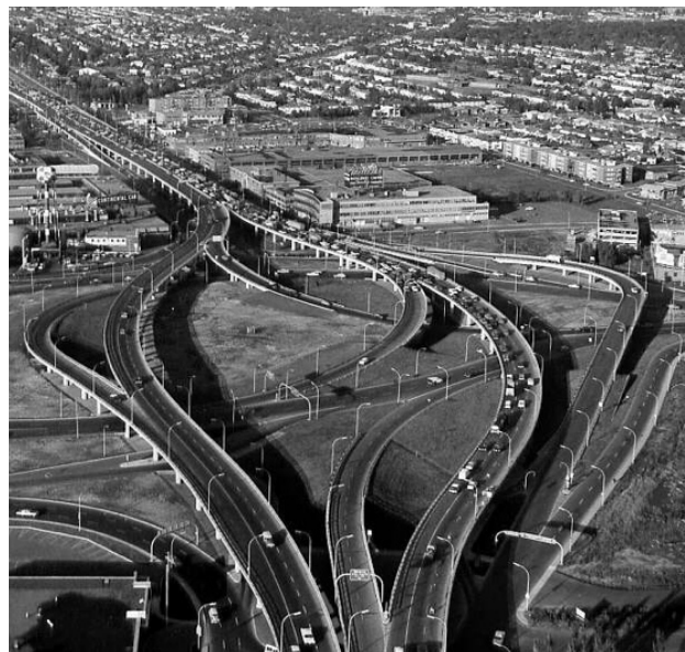
Figure 14 : Ouverture du boulevard Métropolitain à la circulation automobile en 1959 Source : bilan.usherbrooke.ca
