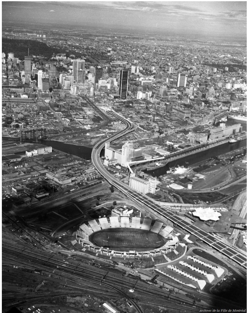
Figure 16 : La construction de l'axe Champlain-Bonaventure en 1966, source : Archives de la Ville de Montréal
