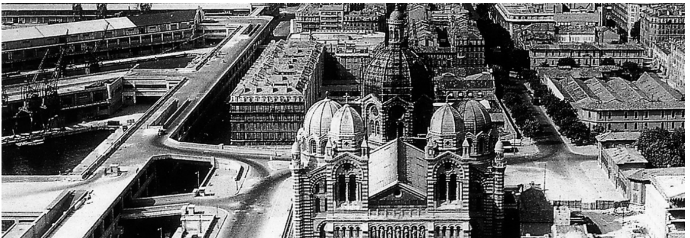
Figure 19 : L'autoroute urbaine à la fois sur pilotis et au sol dans le cœur de la cité phocéenne Source : ArchDaily
