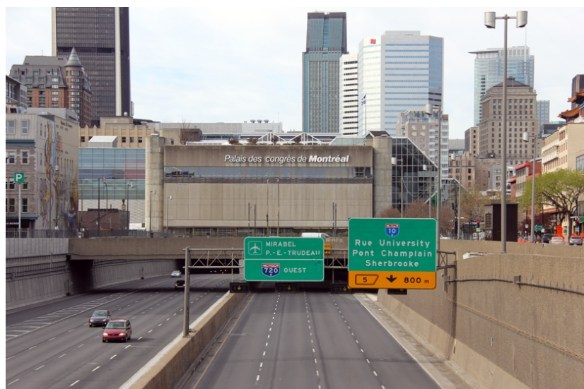
Figure 5 : Photo de l'Autoroute 10 qui traverse Montréal, source : Agglomération de Montréal
