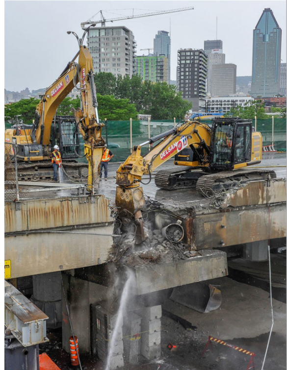
Figure 32 : La démolition de l'autoroute Bonaventure sur pilotis, Source : Ville de Montréal
