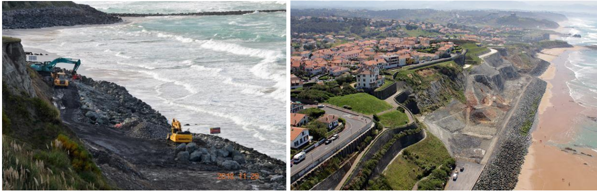
Figure 24 Côte des Basques de Biarritz exemple d'ouvrages de protections de falaise, enrochements en pied et bétonisation (BRGM Nouvelle-Aquitaine 2015)
