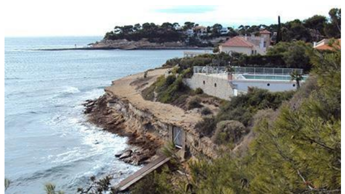
Figure 15 Biens situés en bord de falaise menacés de s'effondrer, Carry-le-Rouet 2016 (projet VALSE 2012-2015)
