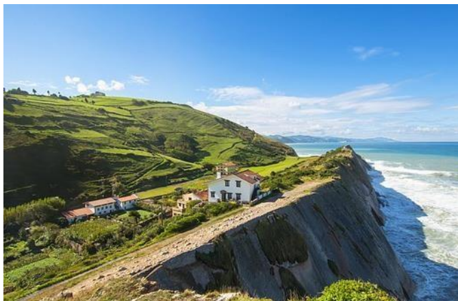
Figure 14 Biens situés en bord de falaise menacés de s'effondrer, Biarritz, 2016 (Sudouest)
