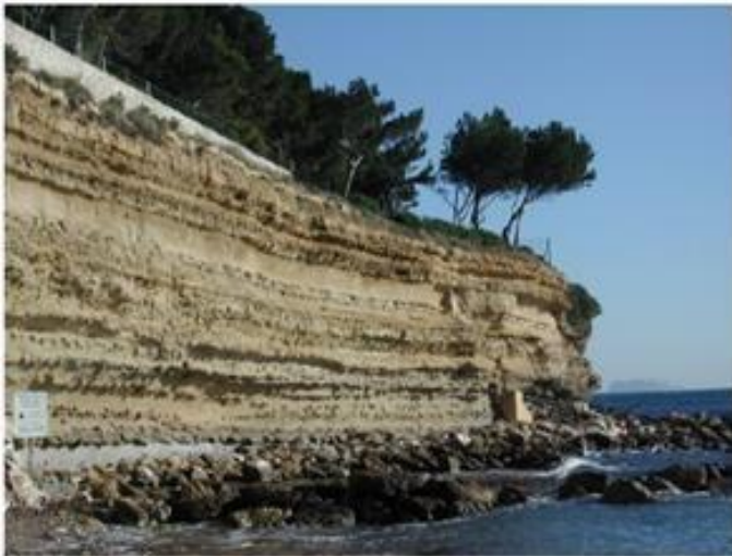
Figure 20 Erosion des falaises à Carry-le-Rouet, 2018 (projet VALSE 2012-2015)
