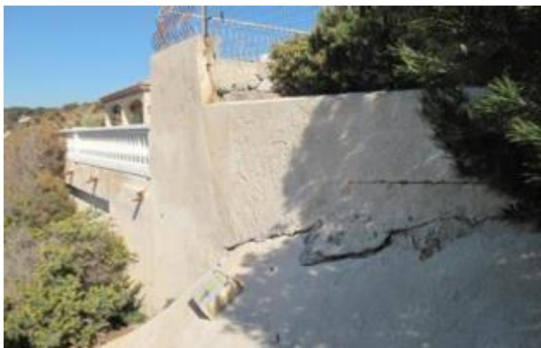
Figure 33 Exemple de parades ayant atteint leurs limites (béton projeté fissuré à gauche sur le sentier du Lézard à Carry-le-Rouet, 2013 (Projet VALSE 2012-2015).
