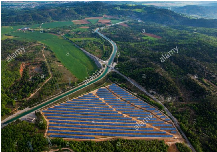
Figure 27 : Parc solaire Vinon-sur-Verdon Source : Alamyimages
