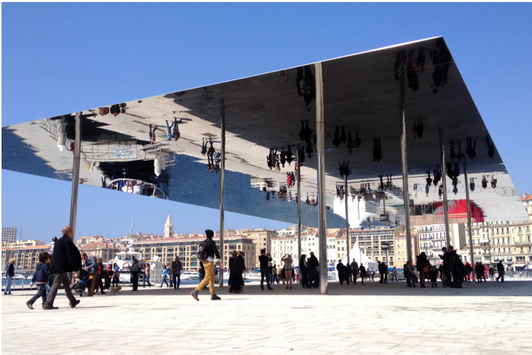
Ombrière de Norman Foster, Vieux Port de Marseille, 2013
