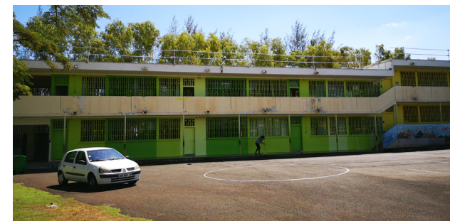
Fig 27 : Une cour peu végétalisée Source: CAUE974, 2019
