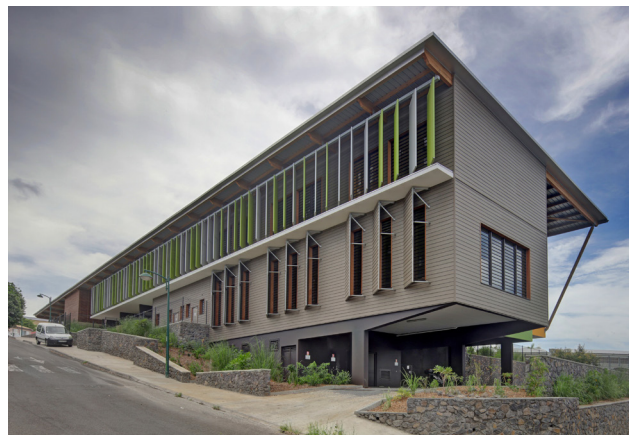
Fig 14 : Le bâti de l'école et ses protections solaires adaptées
