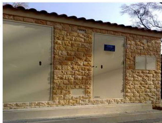
Exemple de revêtements et couleurs RAL pouvant être associé aux locaux techniques (à gauche : RAL 1011 ; à droite : RAL 8000)
