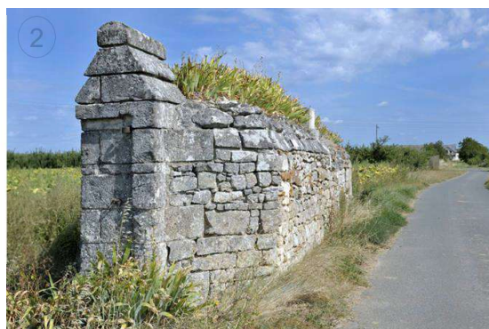
Mûr de clôture vernaculaire à Montsoreau (49)
