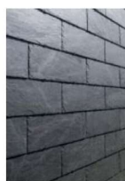
Exemple de revêtements pouvant être associé aux locaux techniques (à gauche : enduit jaune tuffeau ; à droite : bardage en ardoise)
