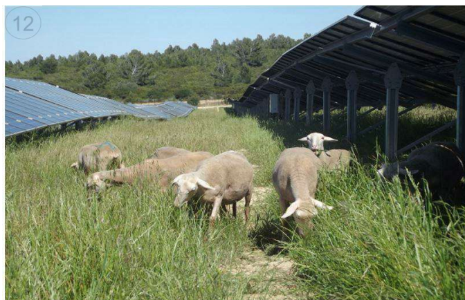
Gestion du sol d'un parc photovoltaïque par pâturage ovin
