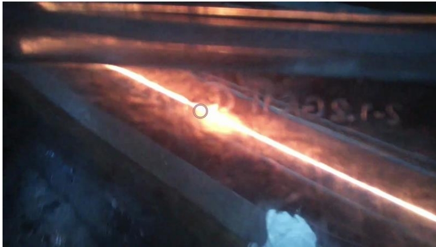
Photo 8 : Le canaliste repère un point chaud sur la baguette de fonte
