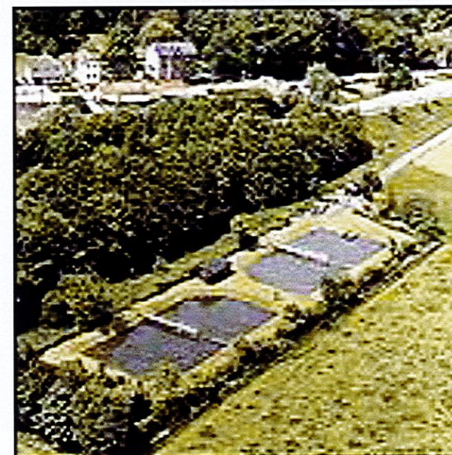
Station d'épuration par lagunage, France
