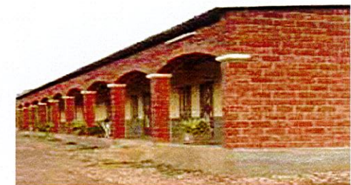
Bobo-Dioulasso, Centre Mater Christi, arcs surbaissés BLT
