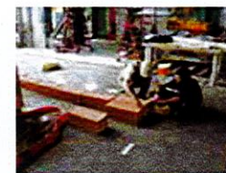
Démarrage d'une voûte nubienne en appui sur un mur tableau. *
