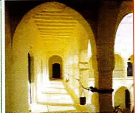
Ombrage et enduit blanc sur construction massive en climat chaud et sec (Tunisie).
