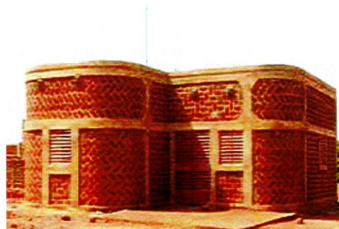
Toma, Habitat F3, L, Murs en BLT.
