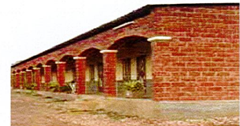
Bobo-Dioulasso, Centre Mater Christi, arcs surbaissés BLT
