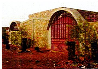
Bobo-Dioulasso, Façade et clôture en grès.
