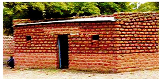
Dano, Célibatorium, BLT mis en oeuvre à l'aide d'un mortier en terre
