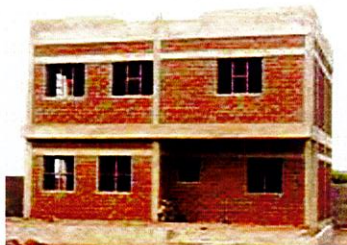
Diébougou Habitat en étage de standing, système mixte BLT en remplissage + ossature Béton
