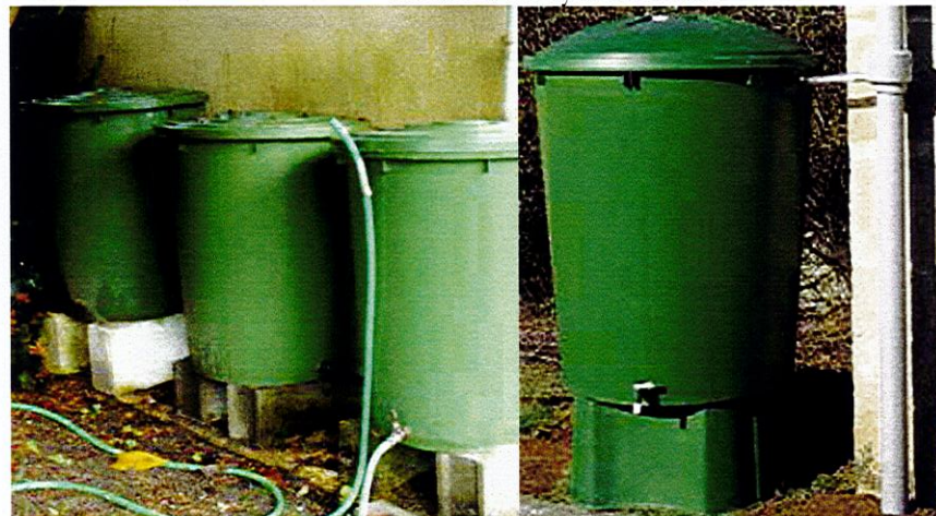
Récipients de récupération des eaux de pluie
