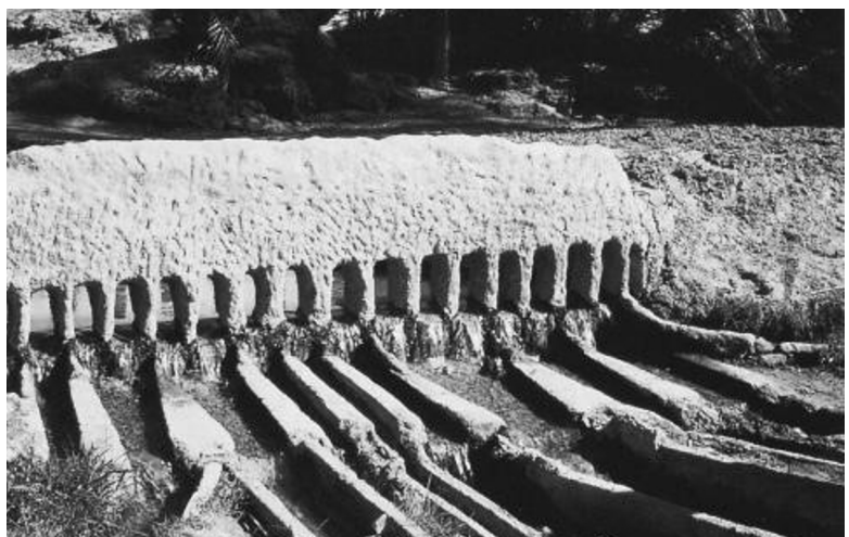
Figure 6 Un peigne-partiteur au débouché d'une séguia de foggara dans la palmeraie de Timimoun © Anonyme.
