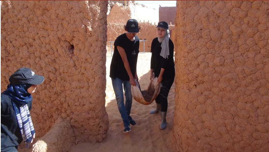
Figure 30 Chantier bénévole « Talmine » © CAPTERRE. Talmine, 2018.
