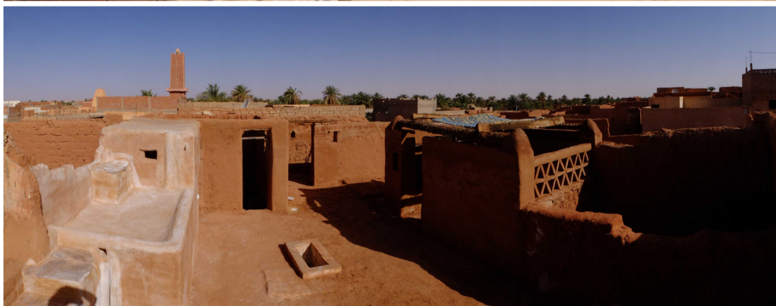
Figure 44 Photos d'avant et après les travaux du chantier école "Dar Zaouïa"
