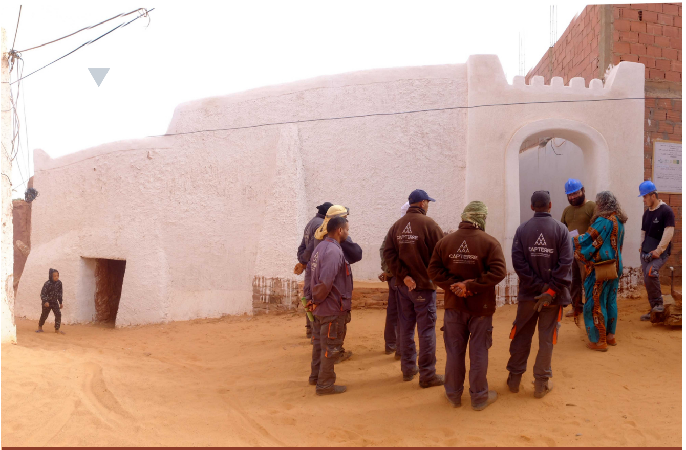
Figure 33 "Dar Zaouïa Sidi Athmane" Avant et après les travaux © S. MORISET, 2018.
