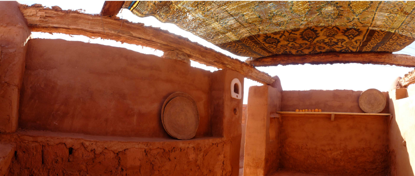
Figure 46 Photos d'avant et après les travaux du chantier école "Dar Zaouïa" ©S. MORISET. Timimoun 2018/2019
