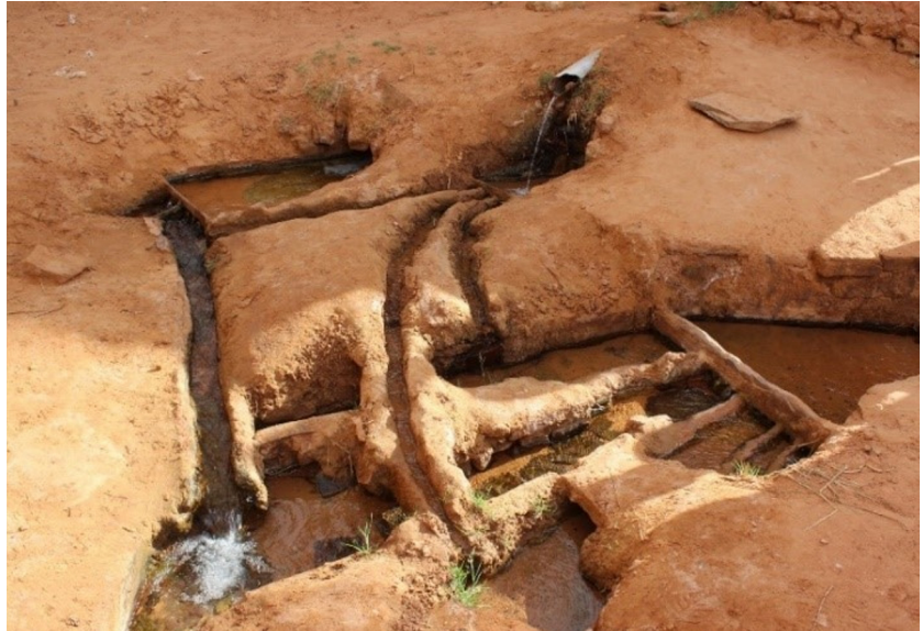
Figure 7 Un peigne-partiteur "Kasria"; bassin de réception dans la palmeraie de Ouled Said © M.HENOUS.
