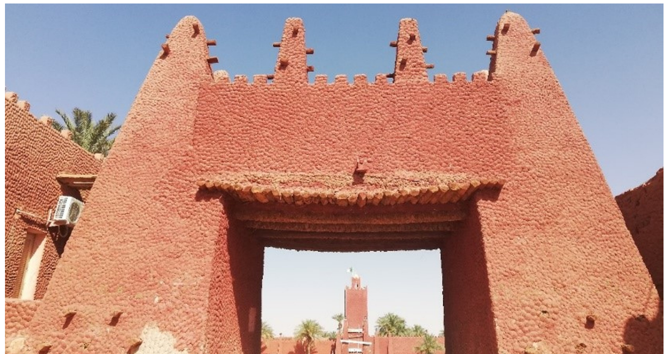
Figure 9 L'ancienne entrée de Timimoun "Bâb Al-Sudan" © M. HENOUS. Timimoun, 2018.
