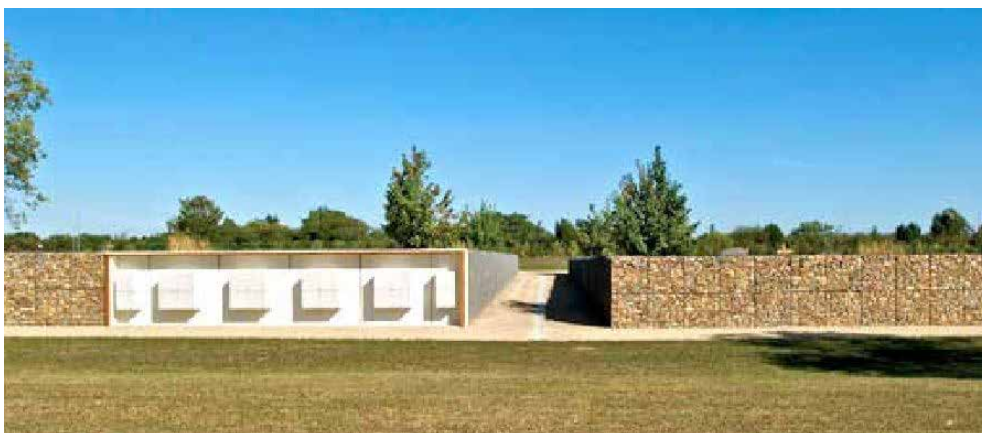
Figure n°17 : Columbariums incrustés dans un mur en gabions, cimetière des Sorinières, source : Agence Philippe Madec
