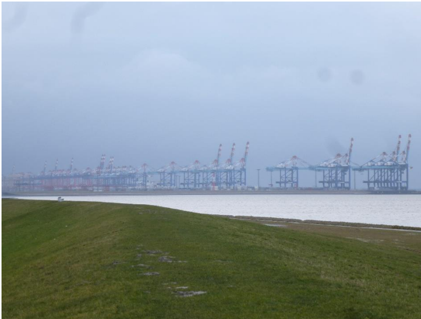
Photographie 21 : le nouveau terminal conteneurs de Bremerhaven, vu depuis la digue de Wremen (Allemagne), 2015. Photographie : Anatole Danto.
