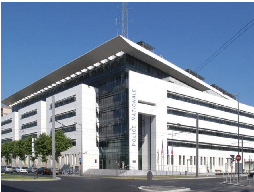
Figure 14 : L'Hôtel de Police de Bordeaux. Ses murs blancs contiennent des nanoparticules de dioxyde de Titane ( \text{TiO}_2 ), utilisées pour leurs capacités autonettoyantes du fait des propriétés de photo-catalyse du \text{TiO}_2 .
