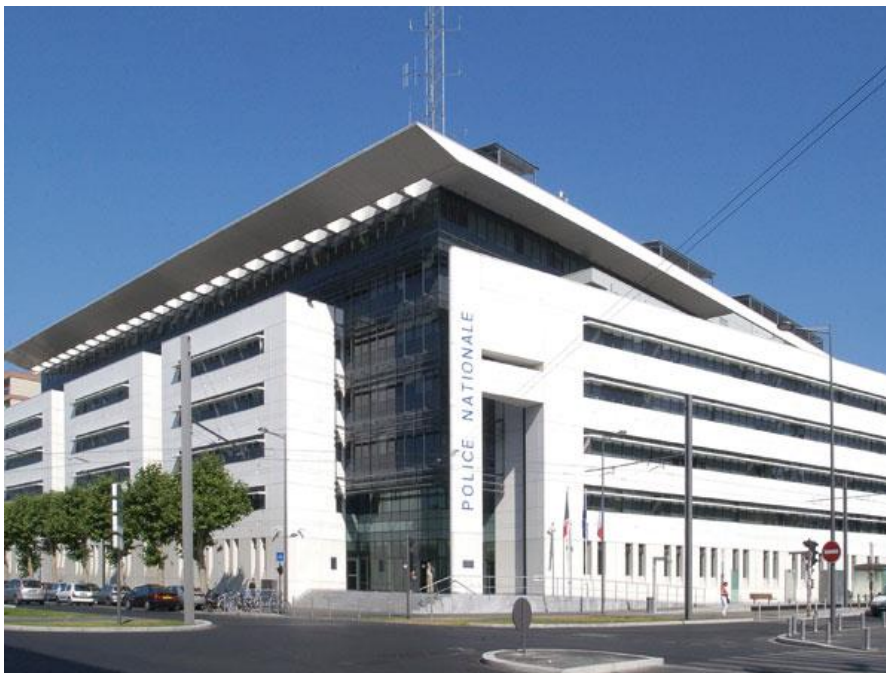
Figure 14 : L'Hôtel de Police de Bordeaux. Ses murs blancs contiennent des nanoparticules de dioxyde de Titane ( \text{TiO}_2 ), utilisées pour leurs capacités autonettoyantes du fait des propriétés de photo-catalyse du \text{TiO}_2 .
