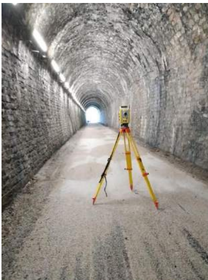
Figure 5 : Lever du tunnel avec le tachéomètre
