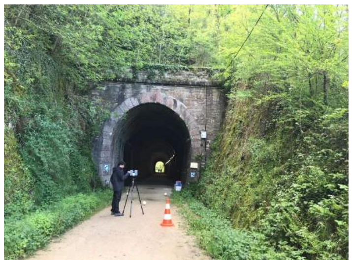
Figure 4 : Lever du tunnel avec le scanner statique
