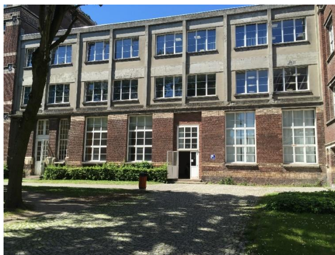
Figure 24 : Façade du bâtiment de l'ICAM, position des mesures réalisées en extérieures - Source : personnelle
