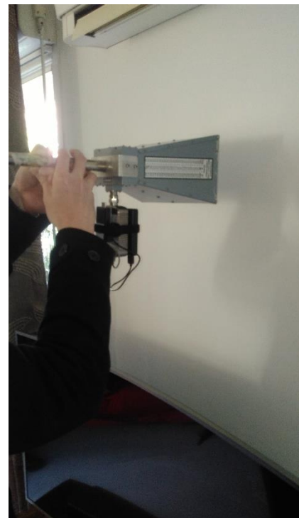
Figure 30 : Prise de mesure sur le mur en béton armé - Source : personnelle
