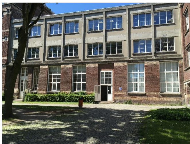
Figure 24 : Façade du bâtiment de l'ICAM, position des mesures réalisées en extérieures - Source : personnel
