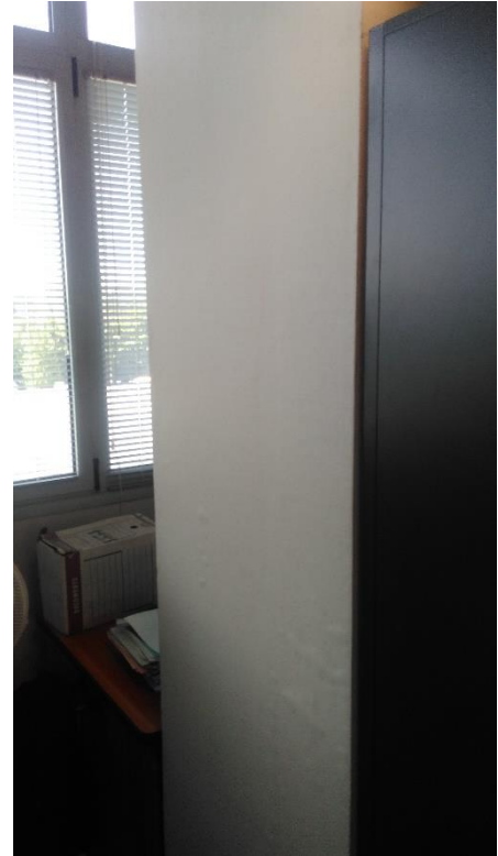
Figure 25 : Pilier circulaire entouré d'un habillage - Source : personnelle
