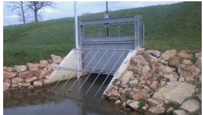
Figure 31 : Ouvrage de rétention temporaire de la Pelleterie (cadre + vanne) Réalisation : Chazé TP, Maîtrise d'œuvre : Artelia. Photo : SBO.
