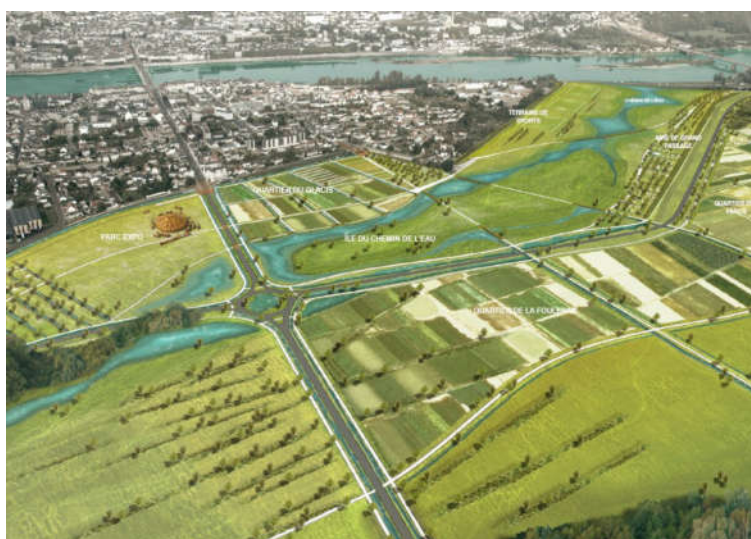
Figure 32 : Déversoir de la Bouillie après l'intervention de l'agglomération de Blois. (Source : ville de Blois, 2015)
