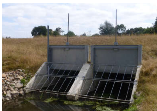
Figure 9 : Ouvrage réalisé sur le site du Tertre (Oudon) par le SBO, mécanisme en crémaillère pour fermer la ZEC. (Source : SBO, 2015)
