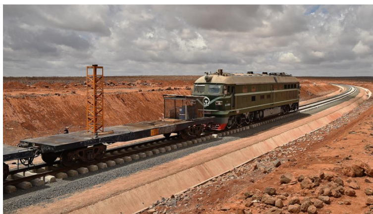
Figure 13 - rénovation de la ligne ferroviaire Adis Abeba – Djibouti, source web
