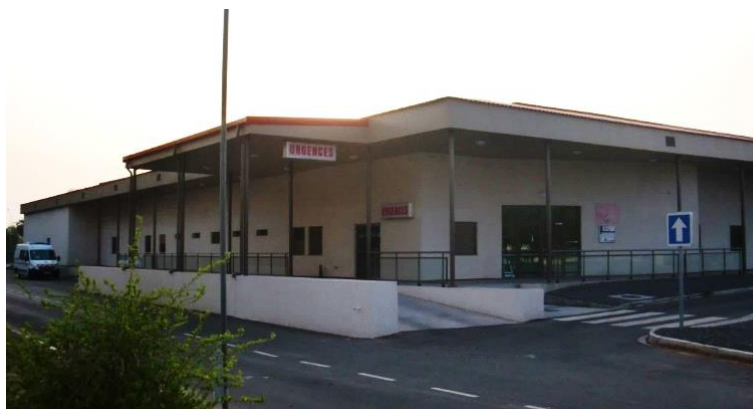
Figure 20 - façade du CMCIA Dominique Matthéï, source : personnele
