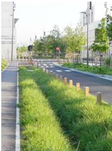
Figure 20 : Une noue végétale, espace à plusieurs usages (Source : Jardins de France, 2016)
