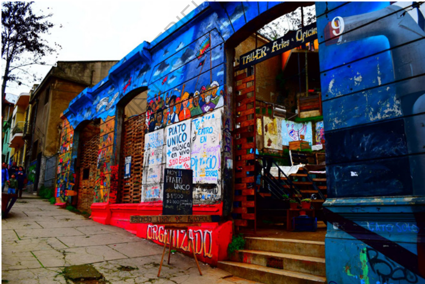
Vue de la façade subida Ecuador. Source : Alejandra Beiza Külaman
