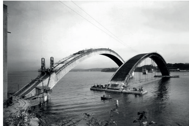
Fig. 8: Le pont de Plougastel introduit le béton pré-contraint d'Eugène Freyssinet, source : www.efreyssinet-association.com
