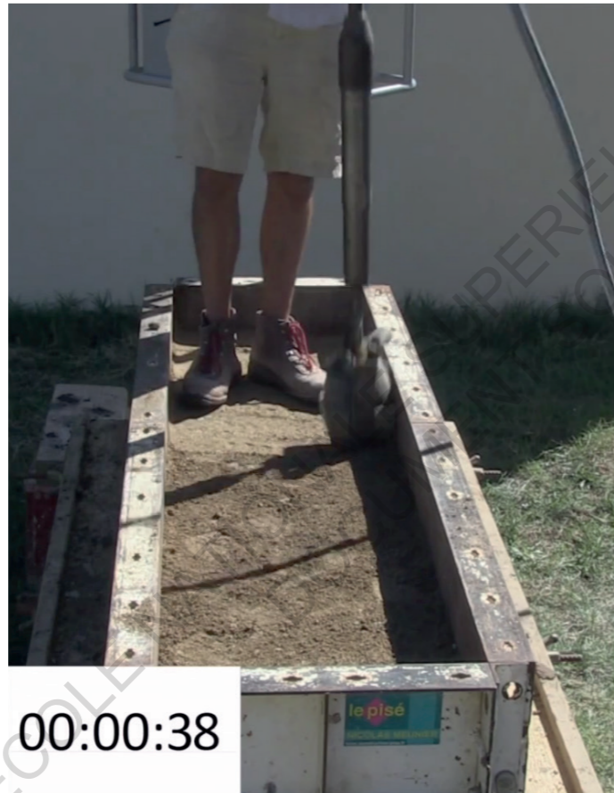
Fig.33 : Le damage courant à l'aide d'un fouloir pneumatique a remplacé le pisoir en bois
