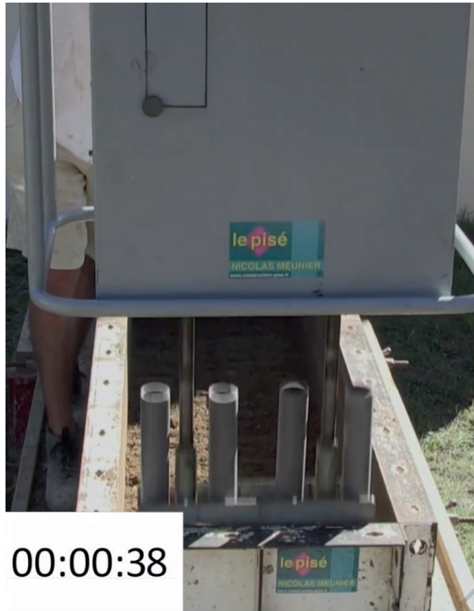
Fig.32 : Le compacteur aérien est bien plus rapide que le fouloir pour damer ces 1m 2 de mur pisé
