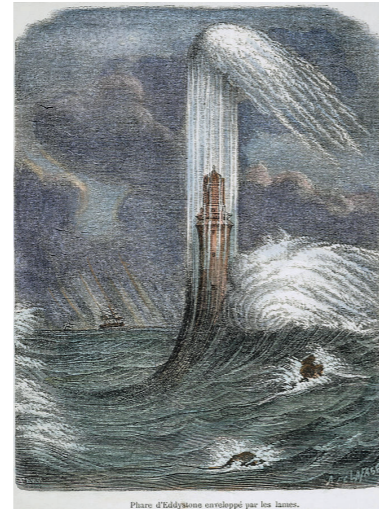
Fig. 4 : Le phare d'Eddystone fait de granit et de chaux hydraulique résiste aux conditions météorologiques peu clémentes de la Manche, source : www.enkidoublog.com , Lafage
