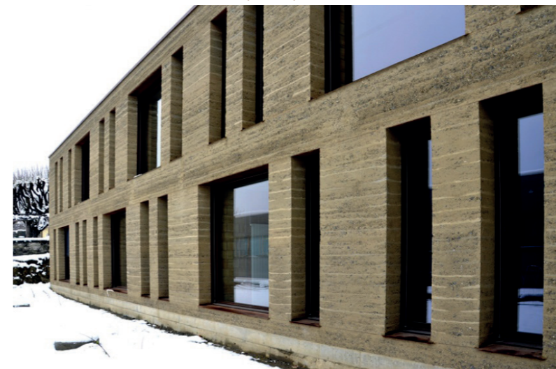
Fig.28: Ecole d'agriculture Mezzana avec strates d'érosion contrôlée, pisé préfabriqué, Martin Rauch, architecte Conte Pianetti Zanetta
