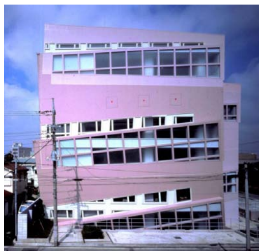
fig. 170 (à gauche) : Diagramme pour le siège de la Nunotani Corporation, Peter Eisenman, 1992 fig. 171 (à droite) : Photographie du siège de la Nunotani Corporation
