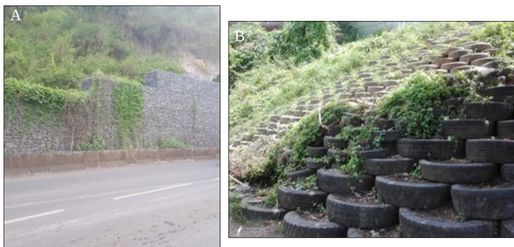
**Figure 3-4:** Interventions face aux phénomènes de mouvements de terrain, gabion sur la RN1 au Nord de Mamoudzou (A) et mur de pneus à l'entrée Nord de Tsoundzou 1 (B) (Clichés : M.Tudoce, 2019)
