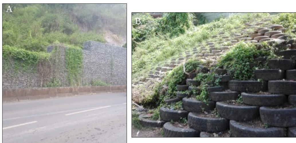
Figure 3-4: Interventions face aux phénomènes de mouvements de terrain, gabion sur la RN1 au Nord de Mamoudzou (A) et mur de pneus à l'entrée Nord de Tsoundzou 1 (B) (Clichés : M.Tudoce, 2019)
