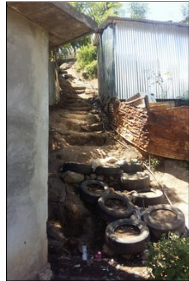
Figure 3-5: Utilisation de pneus en guise de soutènement dans le bidonville de Mlinami à Tsoundzou 1 (Clichés : M. Tudoce, 2019)
