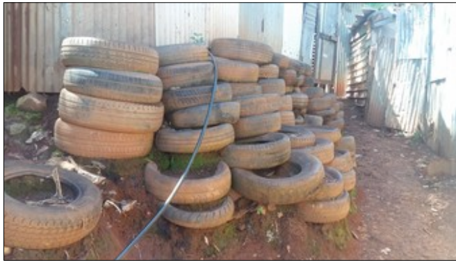
Figure 3-5: Utilisation de pneus en guise de soutènement dans le bidonville de Mlinami à Tsoundzou 1 (Clichés : M. Tudoce, 2019)
