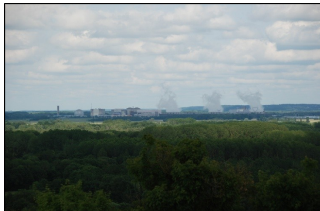
Figure 4 : La centrale, des hauteurs de Candes Saint Martin, situées à 10km du site d'Avoine (L.Couëdel, le 3 juin 2019).
