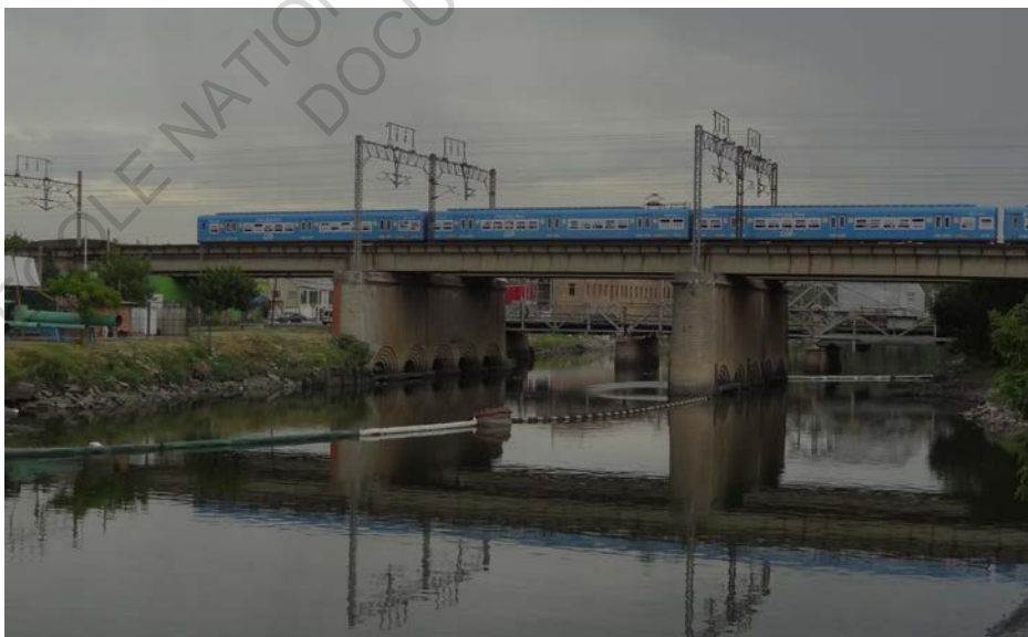
© Photographie : Voie ferrée Roca Source: Mauricio genta
