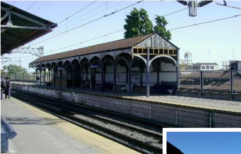
© Photographie : Estación Hipólito Yrigoyen Source: Blog Endless Mile
