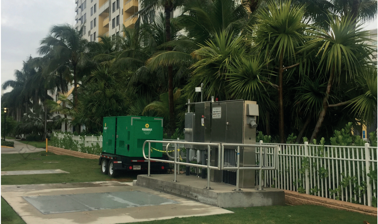
Une pompe et son groupe électrogène
