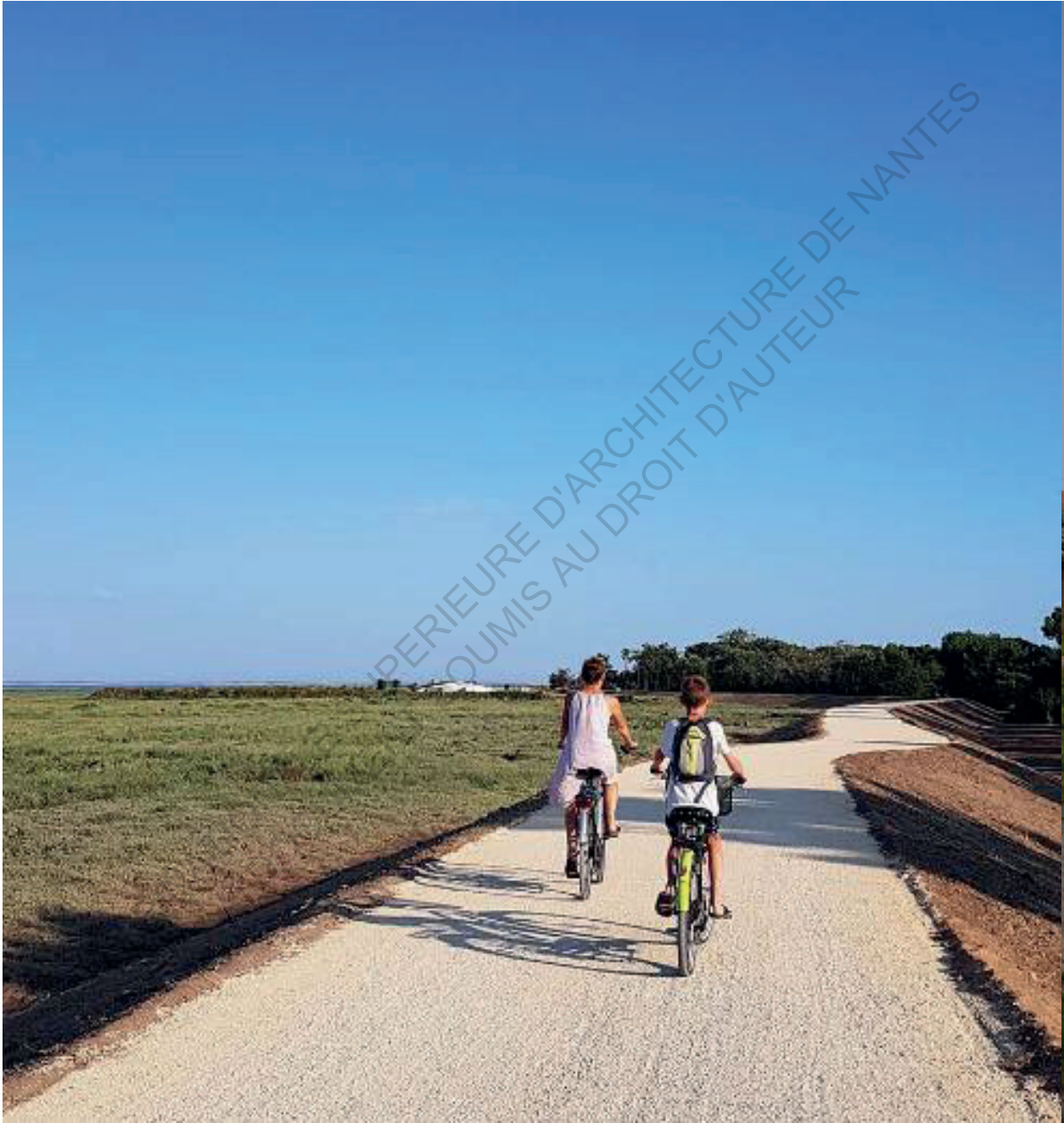
La nouvelle digue de la Faute ©Laurent Huger
