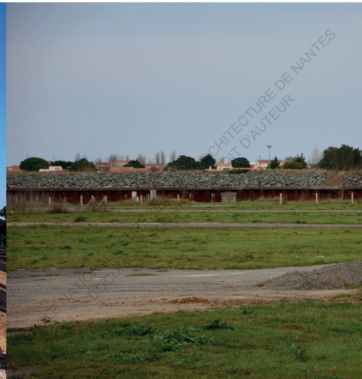
La digue et ses renforcements vue depuis la zone inondée
