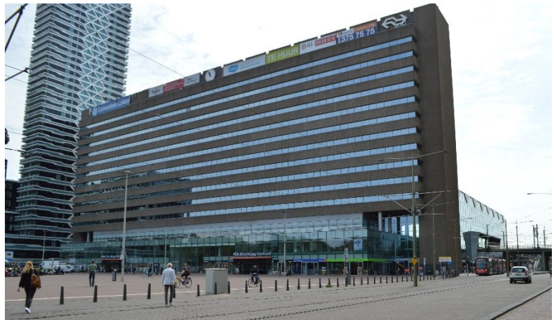
Figure 3 Centraal Station à La Haye (Photo personnelle)
