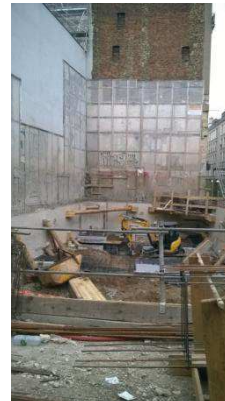
Photo 3 - Chantier en date du 4 août 2017
