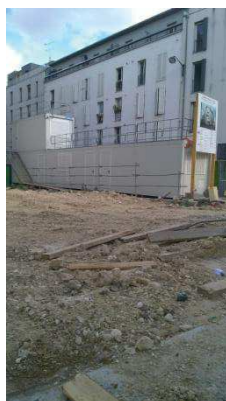
Photo 1 - Chantier en date du 6 mai 2017
