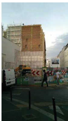
Photo 2 - Chantier en date du 27 juin 2017
