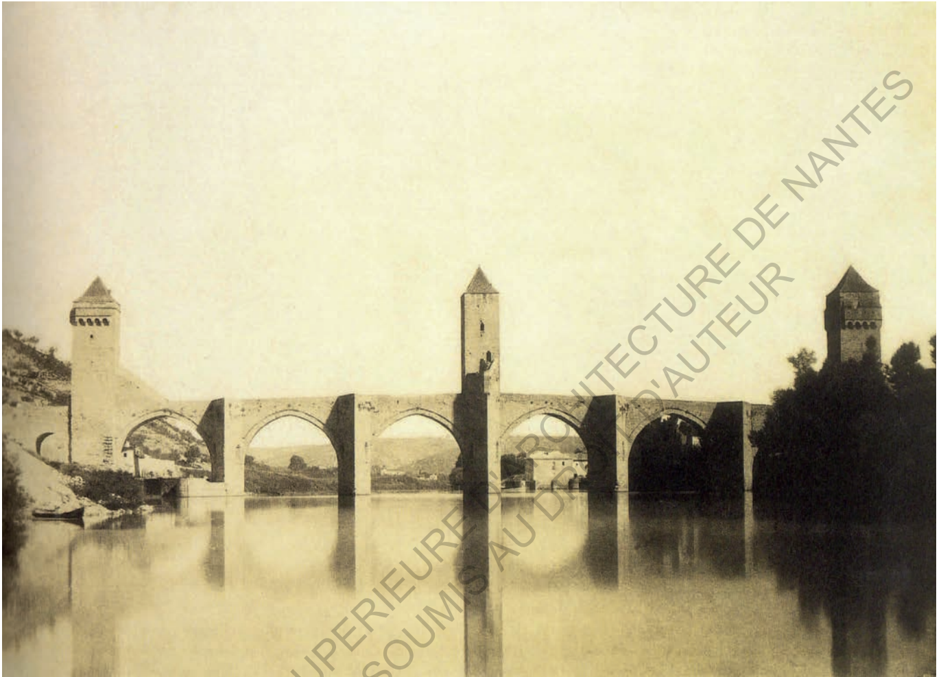
▲ Gustave Le Gray et O. Mestral Vue prise en amont, pont Valentré, Cahors (Lot), 1851 [21], © La Mission héliographique, cinq photographes parcourent la France en 1851
