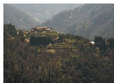
Un habitat ponctuel dicté par la topographie de la vallée (crête, replat et sommet habités)
