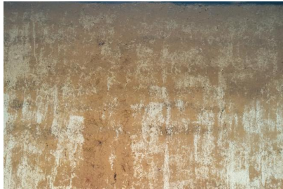
Trous laissés par le coffrage (pisé) et remplis par la terre.
