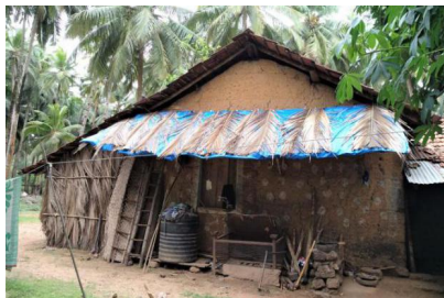
Débordements, les maisons à Goa.
