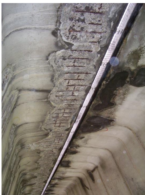
Intrados - Viaduc du Chéran
