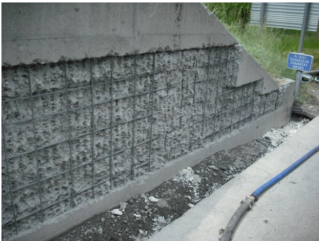
A 43 – PI 3001 Travaux de réparation sur les piédroits - 2010
