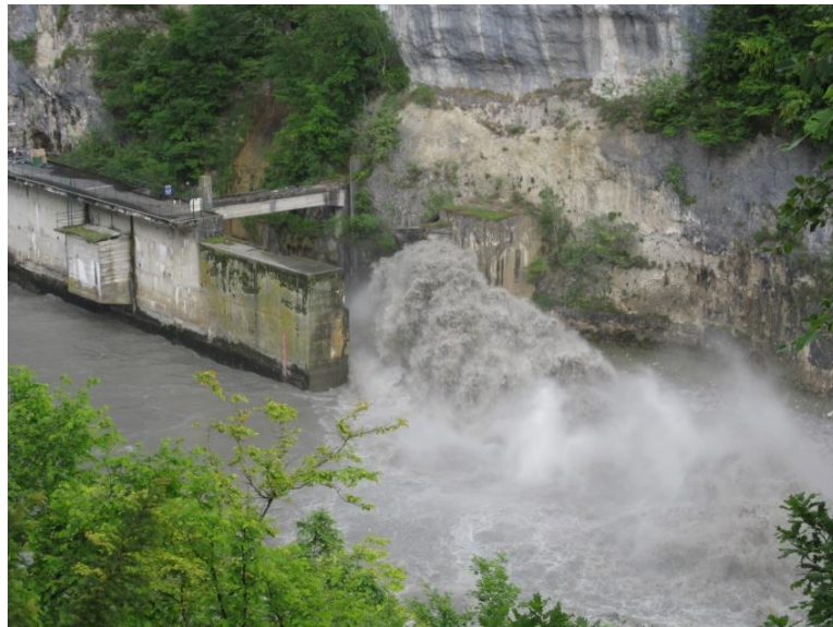
Figure 5 : Sortie de la vanne de demi-fond du barrage de Génissiat lors des chasses du Rhône [Henry E.]
