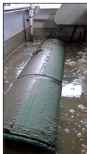
Photo 16 : Tambour lors d'un cycle de lavage
