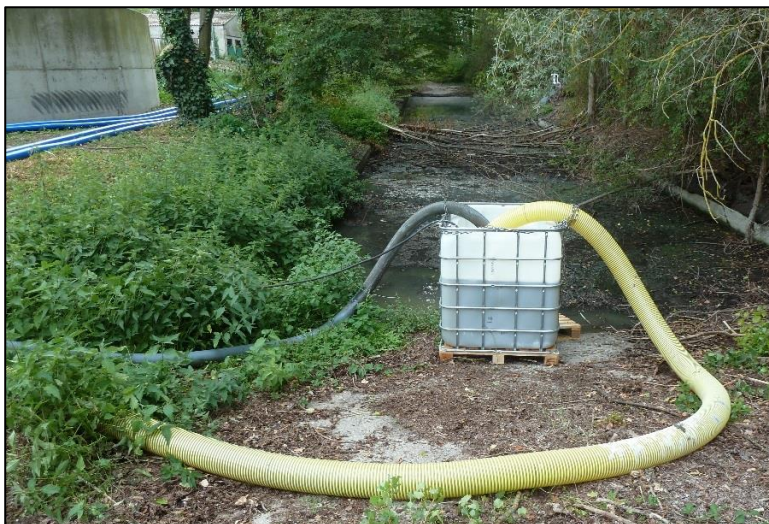
Photo 17 : Sortie du filtre pilote et dispositif de réception des eaux traitées
