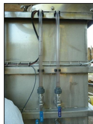
Photo 15 : Tubes de niveau, niveau de l'eau à filtrer (g.) et de l'eau filtrée (d.)
