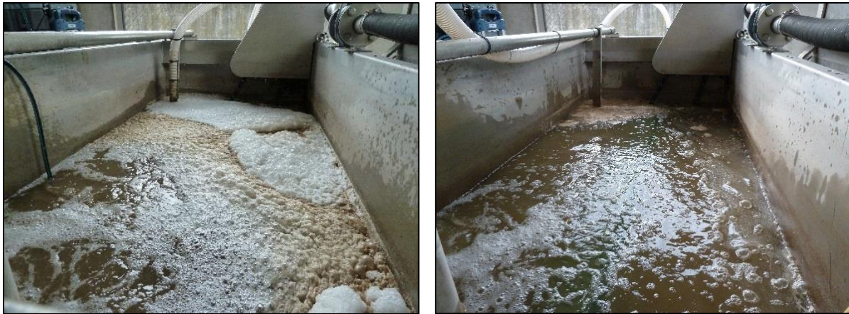
Photo 33 : Présence de mousse à la surface du filtre. A gauche lorsque la solution commerciale (HYDREX 6798) est injectée pure et à droite lorsqu'elle est injectée après une dilution au préalable.
