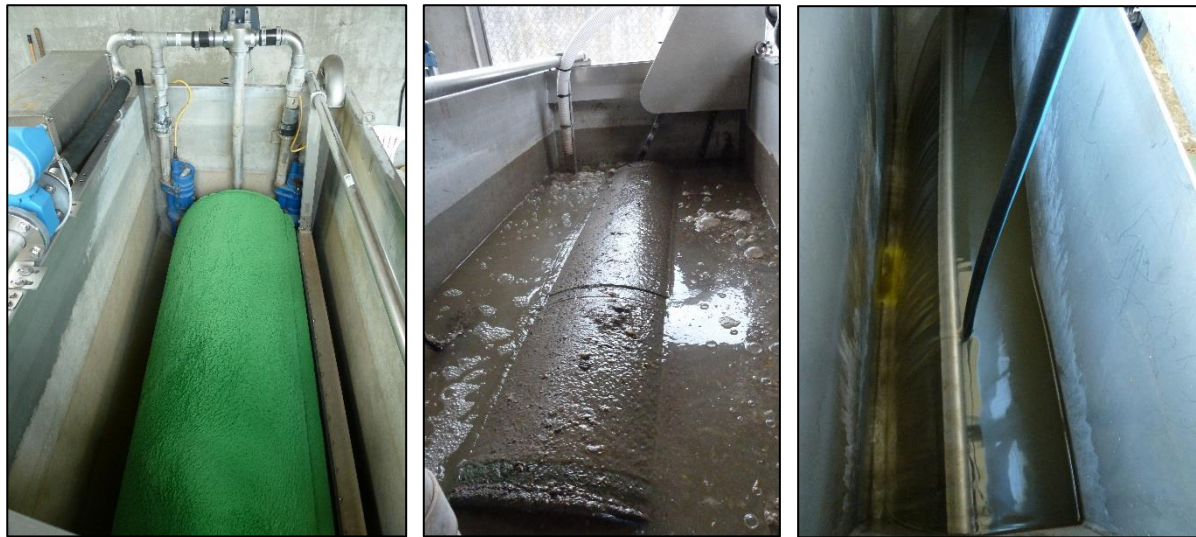
Photo 14 : Tambour avec médiateur filtrant propre et en action de filtration ainsi que le déversement des eaux filtrées dans le canal montant et du trop-plein d'urgence.
