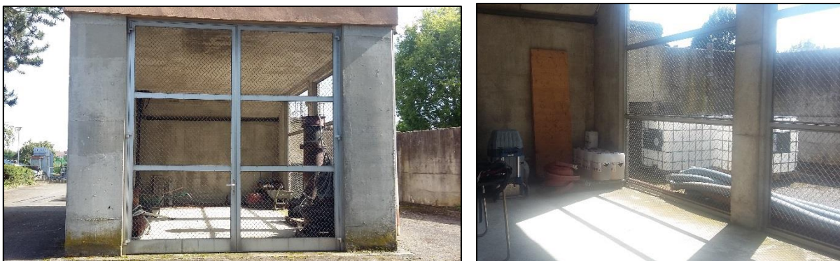
Photo 4 : Local d'accueil du filtre pilote.
