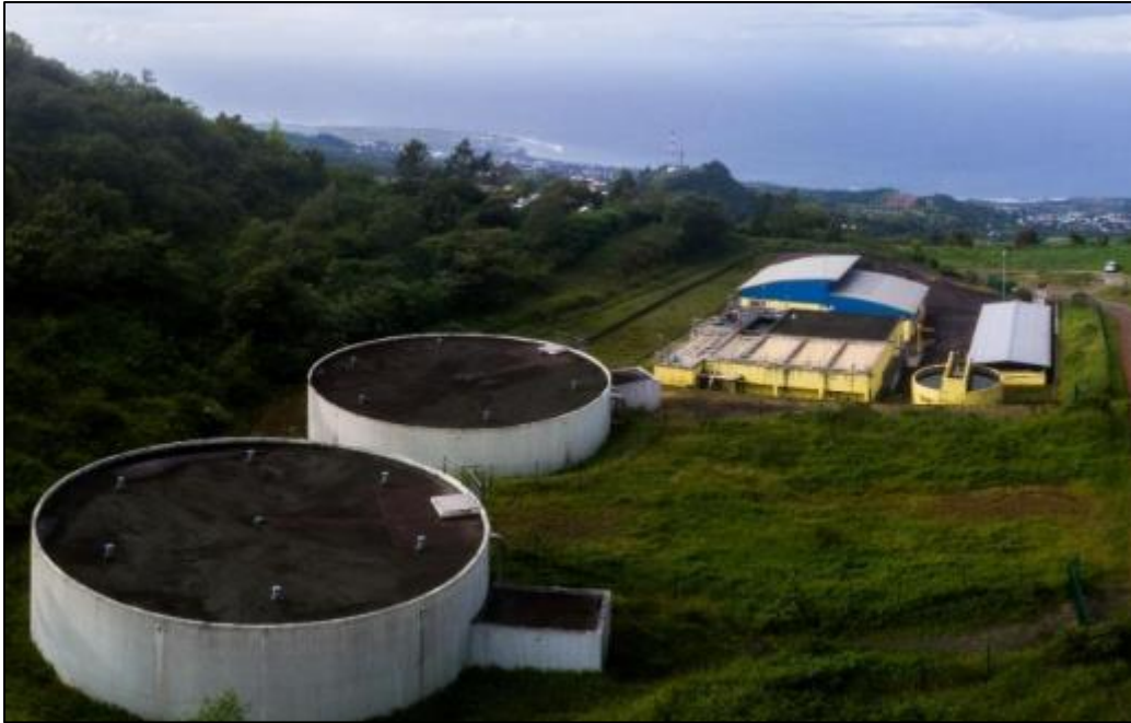
Figure 5 : Station de potabilisation du Plate (Source : RAD 2018)
