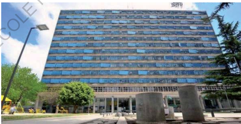
Façade du ministère des infrastructures. Source : site web du ministère
