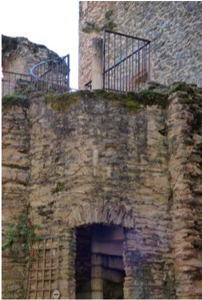
Escalier à vis de la cour (CdA)
