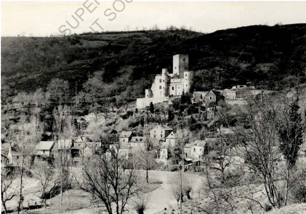
Photographie pendant les travaux en 1981 (Source STAP Aveyron)
