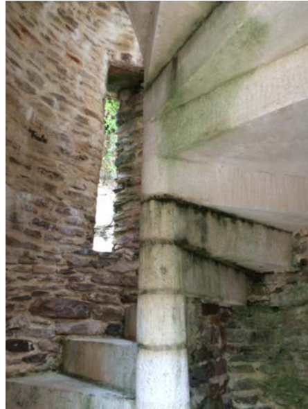
Escalier à vis de la cour (CdA)
