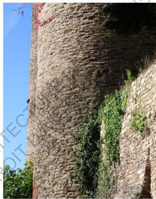
Reconstruction du haut d'une tourelle (CdA)
