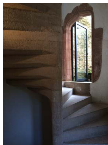
Escalier à vis central (CdA)
