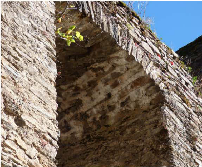
Bouchonnage d'une brèche (CdA)
