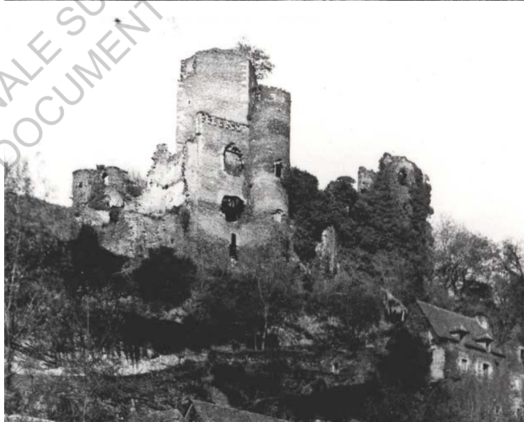
Photographies du château avant restauration (Source STAP Aveyron)
