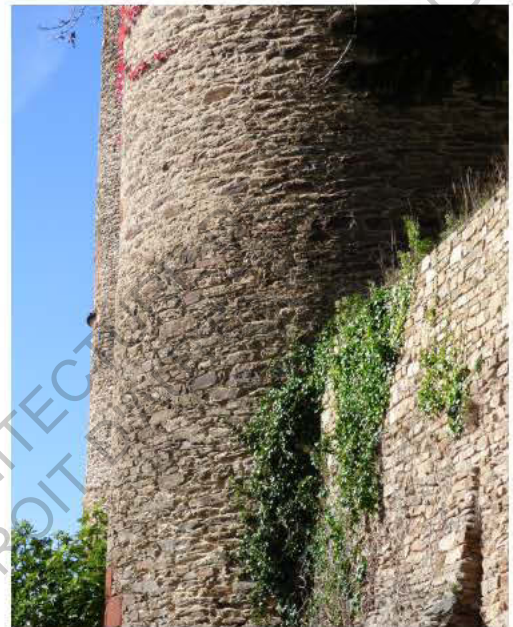
Reconstruction du haut d'une tourelle (CdA)
