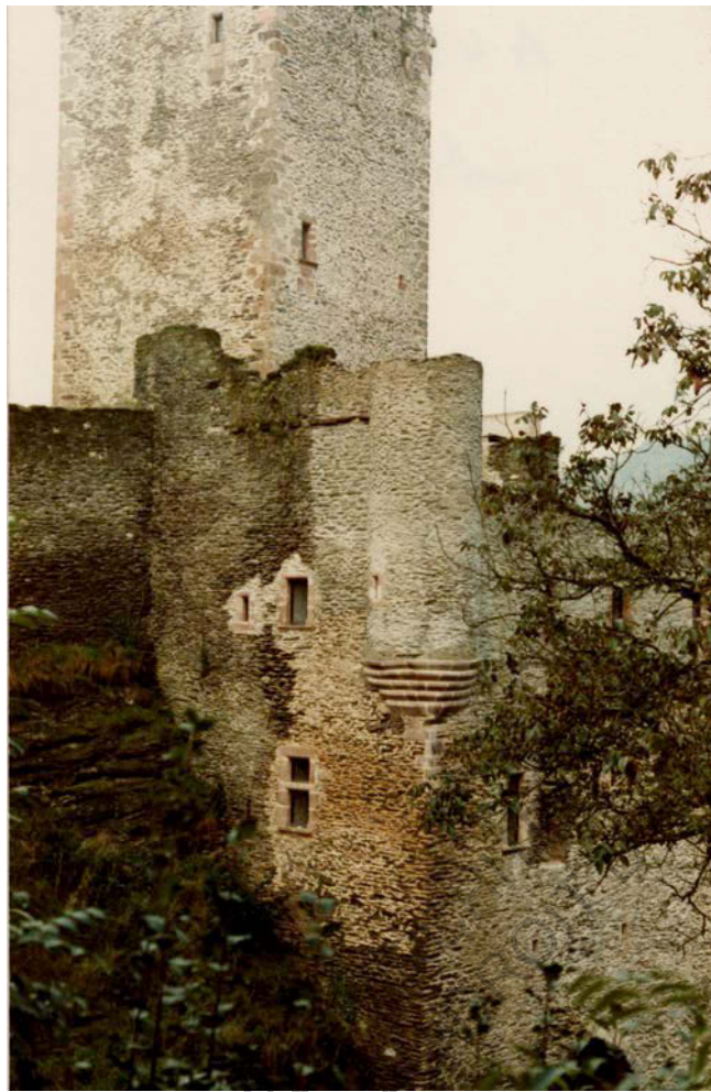
Photographie pendant les travaux en 1980 (Source STAP Aveyron)
