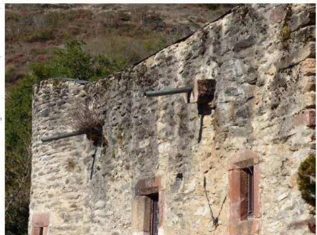
Toiture terrasse finalement réalisée (CdA)
