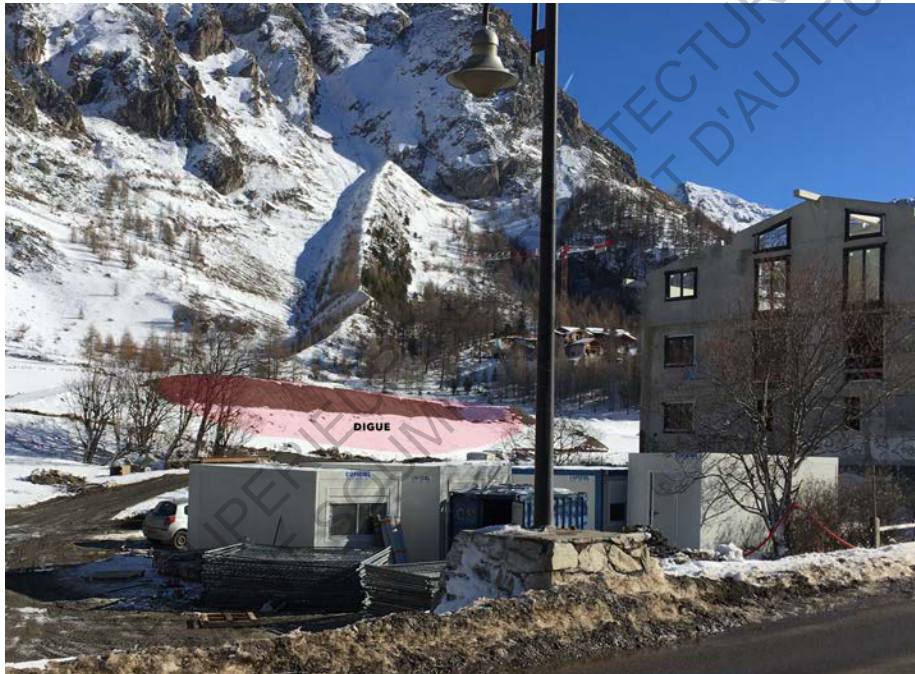
- UNE DIGUE PROTÈGE LE CHANTIER QUI À REPRIS PENDANT L'ÉTÉ 2017 -
