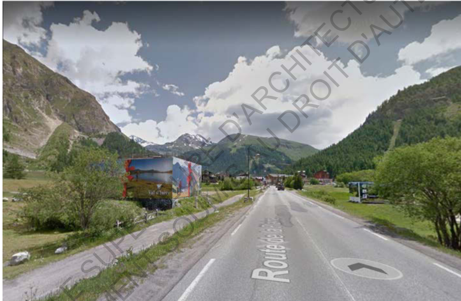
- CHANTIER DU PARKING DE LA DAILLE EN JUIN 2014 -
