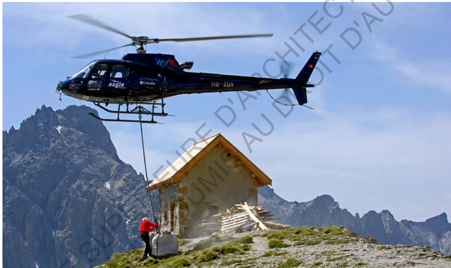
- HÉLICOPTÈRE ASSISTANT UN CHANTIER EN ALTITUDE - - PHOTOGRAPHE INCONNU - SOURCE: WWW.CEILLAC.COM -
